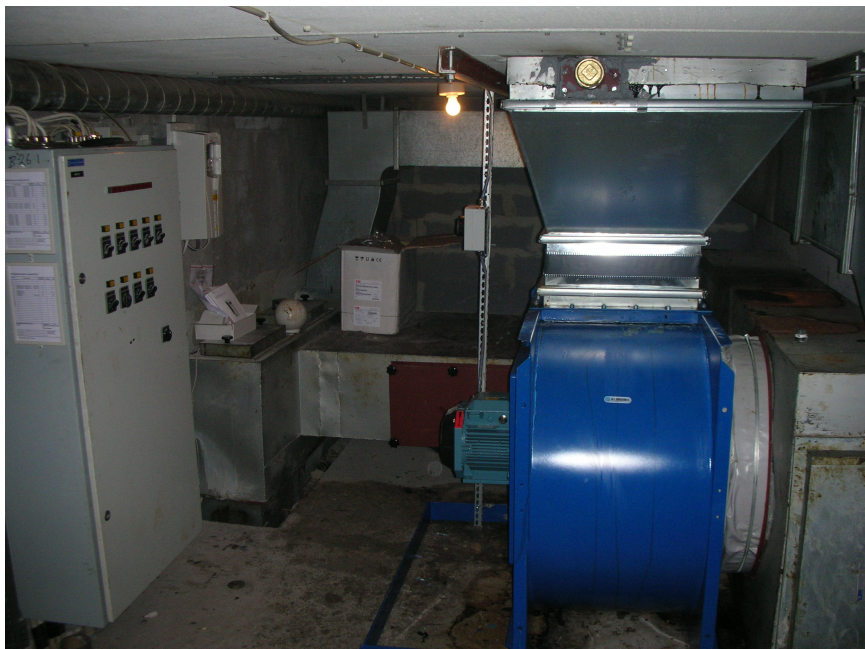
Figur 1 Provtagningsstudds för provtagning av ventilationsluft efter fläkt.
